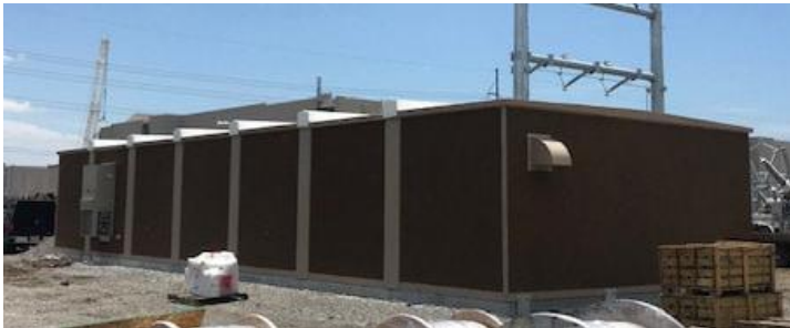
63'L x 12'W x 13'H concrete enclosures
